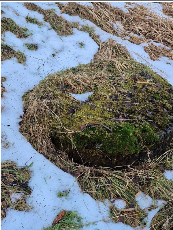
Figur 2-6: Kjøde 19-3. Gravdbrønn med overføringsledning til samleikum Kjøde 19.
