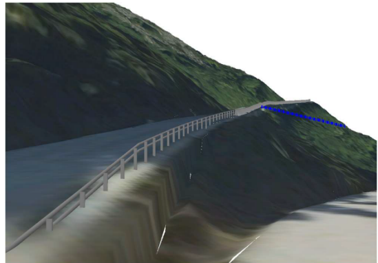
Stålrekkverk i retning Mannseidet
