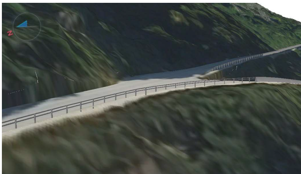
Eksisterande kryssutforming der dagens betongrekkverk er erstatta med transparent stålrekkverk
